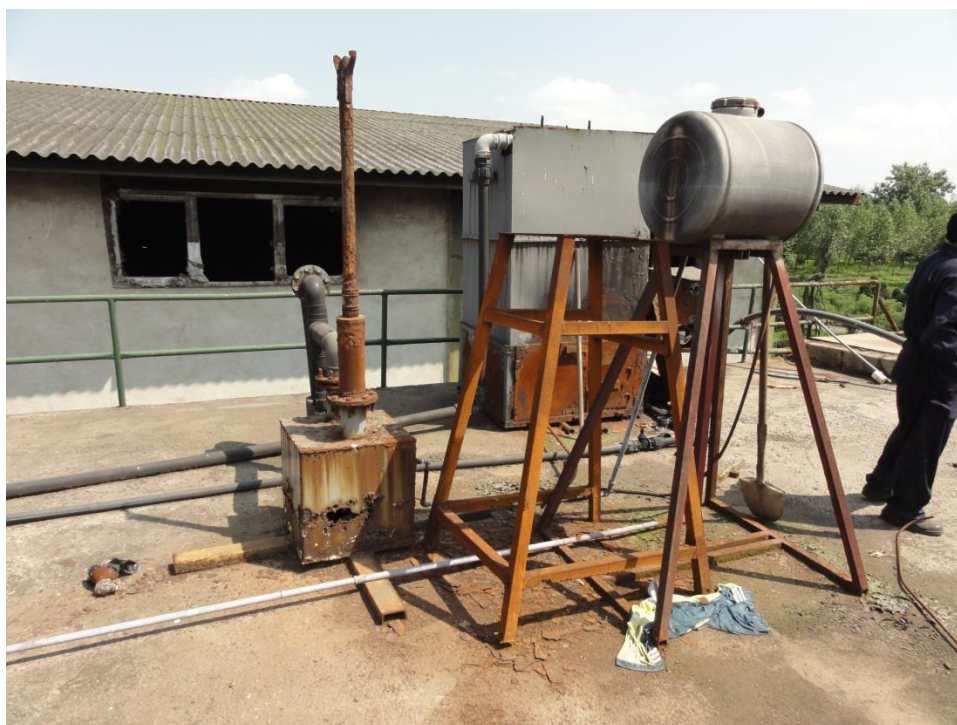
شکل (۲) - سیستم گرمایش و مشعل مستهلک شده فاز بی هوای فرایند تصفیه شیرابه کمپوست رشت
