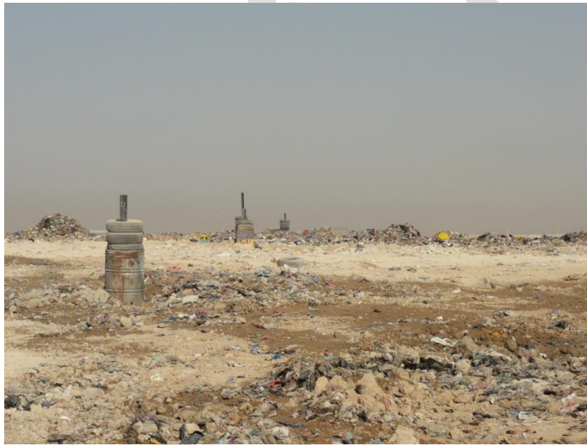
شکل (۱)- محل جدید دفن زباله های شهر اهواز همراه با شبکه جمع آوری گاز و شیرابه
